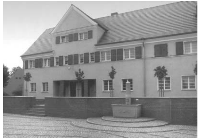
Industrielles Gartenreich: denkmalgeschützte Siedlung Piesteritz (Wittenberg). Abschluss der Erneuerung, 2000
